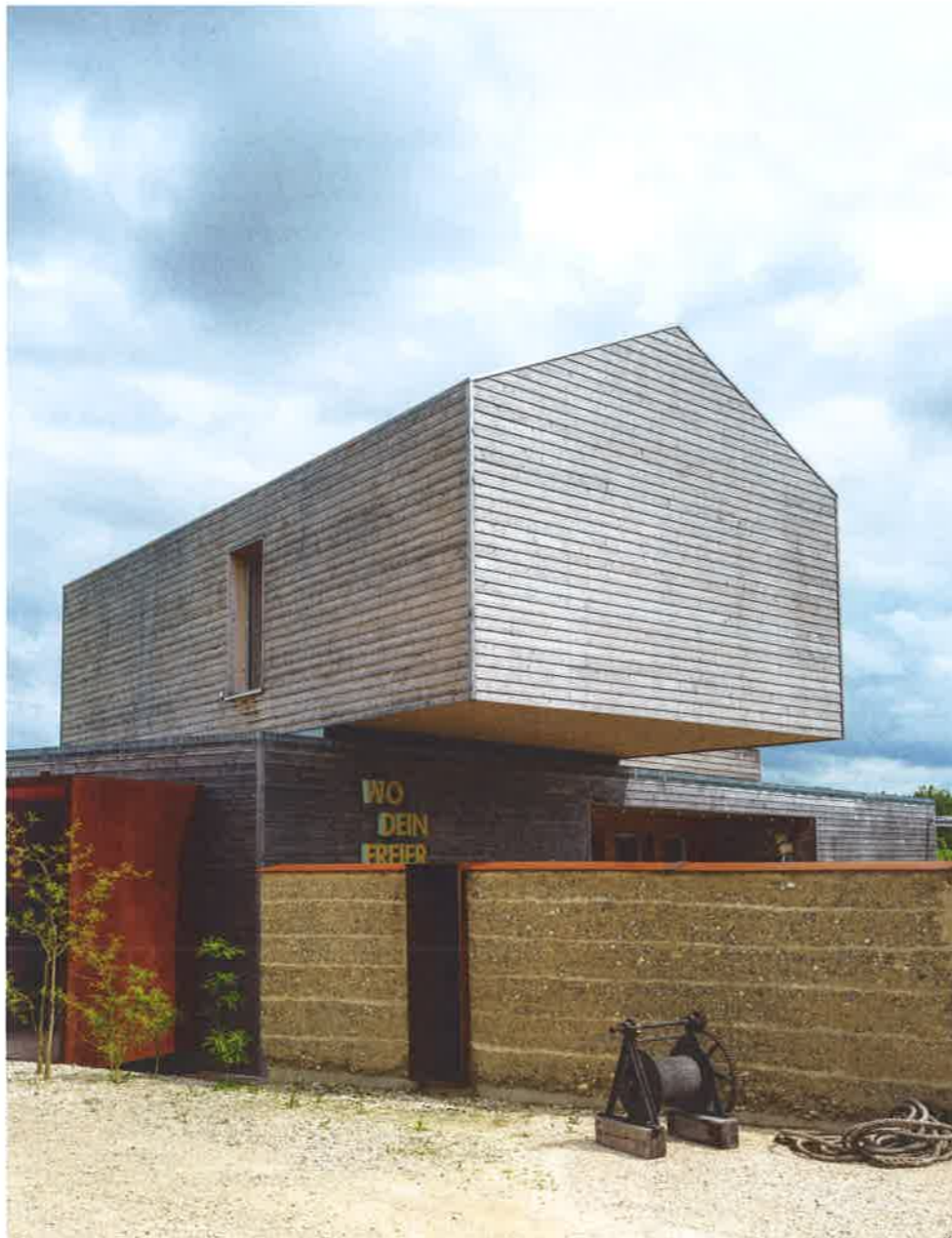
Sichtschutzwände aus Lehm, Skulpturen aus Metall und ein Bauwerk aus Holz prägen das Erscheinungsbild des Kunst-Hofs. Da es sich um ein Gebäude mit geringen Abmessungen handelt, waren keine speziellen Brandschutzanforderungen gestellt. Zur Isolierung ist der Holzrahmen mit Zelluloseflocken gefüllt. Das Atelier entspricht dem Minergie-Standard (ohne Zertifikat).
